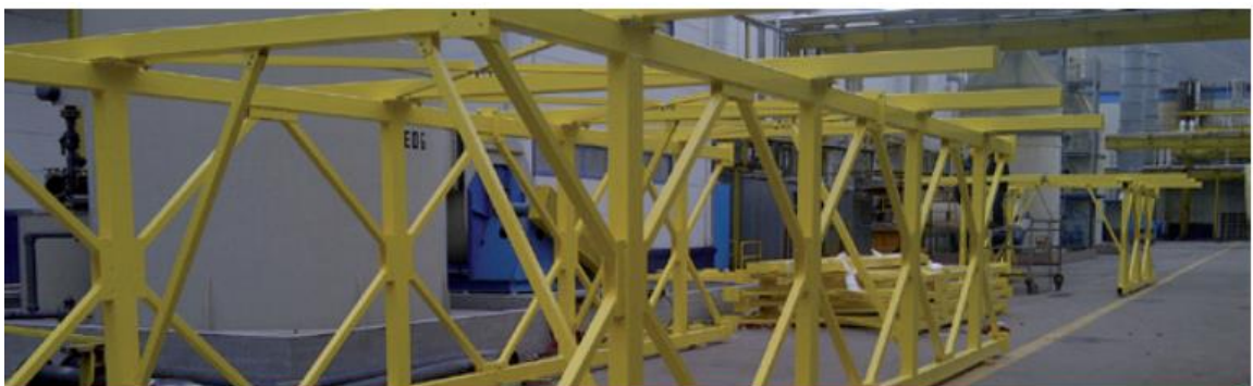
• Struttura Sopraelevata (Nola)
